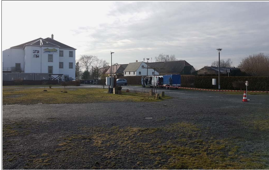
Abb. 1: Blick Richtung Westen auf das Gelände des geplanten Sanitärgebäudes
